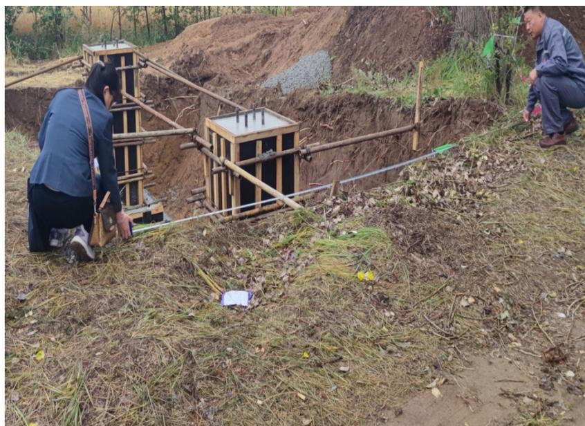
塔基开挖基础测量 (2023.9)
